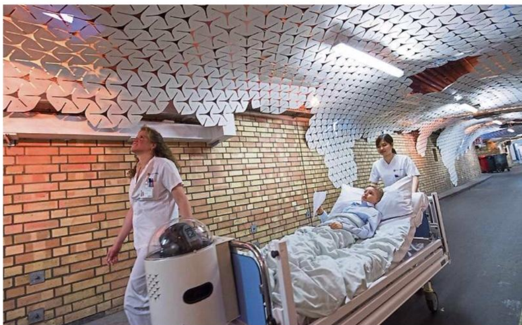
Der einst abweisende und bedrückende unterirdische Gang zwischen Kinderchirurgie und OP-Sälen ist neu gestaltet. Die Decke mit ihren Leuchten, Rohren und Leitungen ist mit 800 Alu-Paneelen verkleidet, auf die ein sogenannter „Moving Head“ vorn am Bett einen pfeilförmigen Papierflieger projiziert, der den jungen Patienten durch die Tunnelstrecke begleitet und ablenkt.
